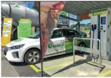
Schnellladestation mit integriertem 100-kW-Speicher bei der Landi Matzingen.
